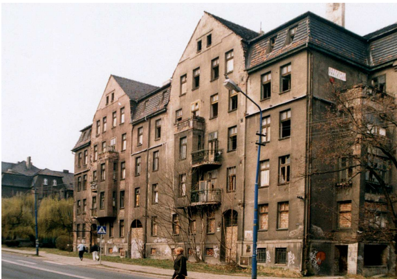
Mysłowice, ul. Mikołowska, przed remontem.
