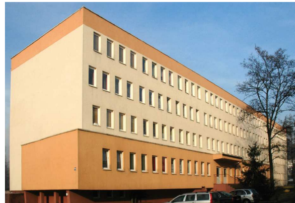
Mysłowice, ul. Reja, po remoncie.
