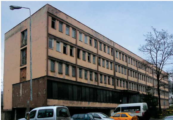
Mysłowice, ul. Reja, przed remontem.
